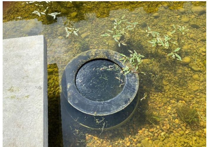
Abbildung 3: im Filterbett verbauter Skimmer 360°
